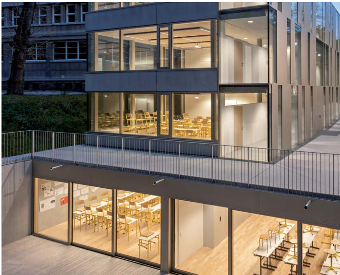
Projet pilote d'extension du lycée français et rénovation Studio Molière, Vienne, Autriche (2016) © Dietmar Feichtinger Architectes
