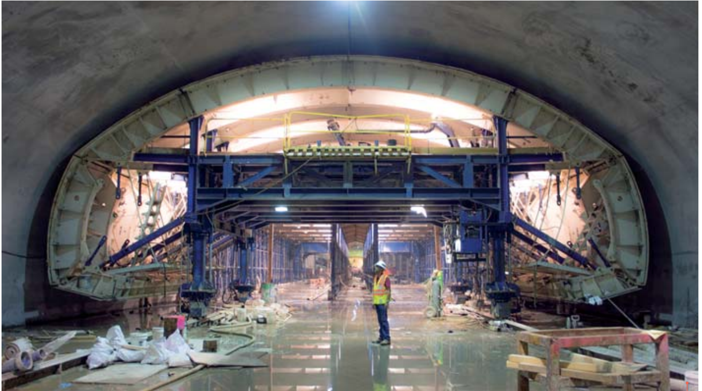
Travaux du métro de Second Avenue, New York, 2013. MTA Capital Construction/Rehema Trimiew/Wikimedia, © BY-SA
