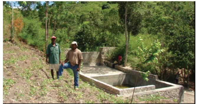
Figure 1. Un seuil (C28) vu de l'aval. Noter le bassin (80 m3) et le radier.
