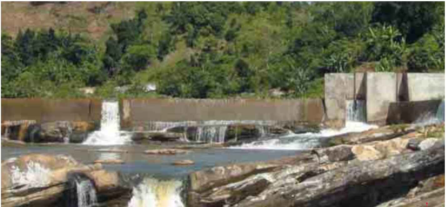
Barrage au fil de l'eau pour le site hydroélectrique de Sahasinaka - Source: GRET
