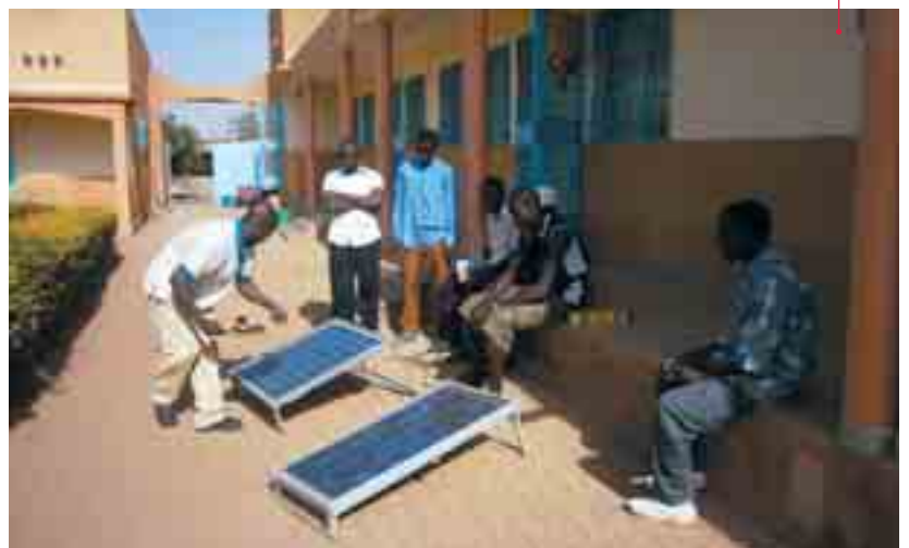
Formation technique initiale des installations de BETA pour MICRESOL Source : Fondem
