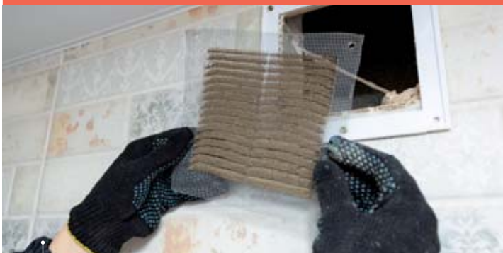
Remplacement d'un filtre de ventilation
