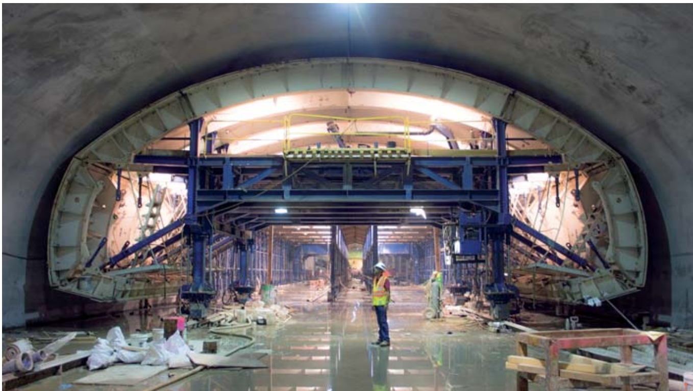
Travaux du métro de Second Avenue, New York, 2013. MTA Capital Construction/Rehema Trimiew/Wikimedia, © BY-SA
