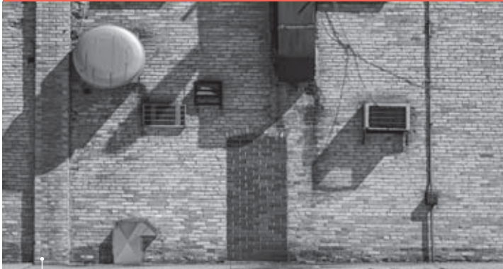
Unités de ventilation sur la façade d'un bâtiment
