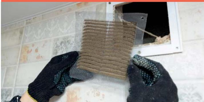
Remplacement d'un filtre de ventilation
