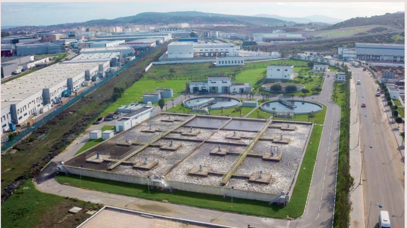
Station d'épuration des eaux usées de Boukhalef opérée par Amendis - ©Veolia
