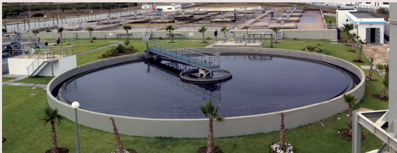
Les eaux usées de la STEP de Boukhalef sont utilisées pour l'arrosage des golfs et des espaces verts municipaux à Tanger - ©Veolia
