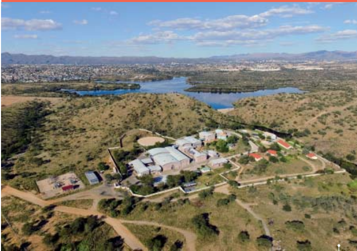
Usine de recyclage des eaux usées à Windhoek - ©Veolia
