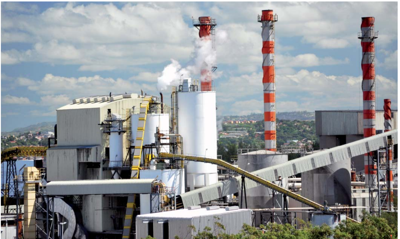
À Durban les eaux usées sont réutilisées pour répondre aux besoins des industriels -©Veolia
