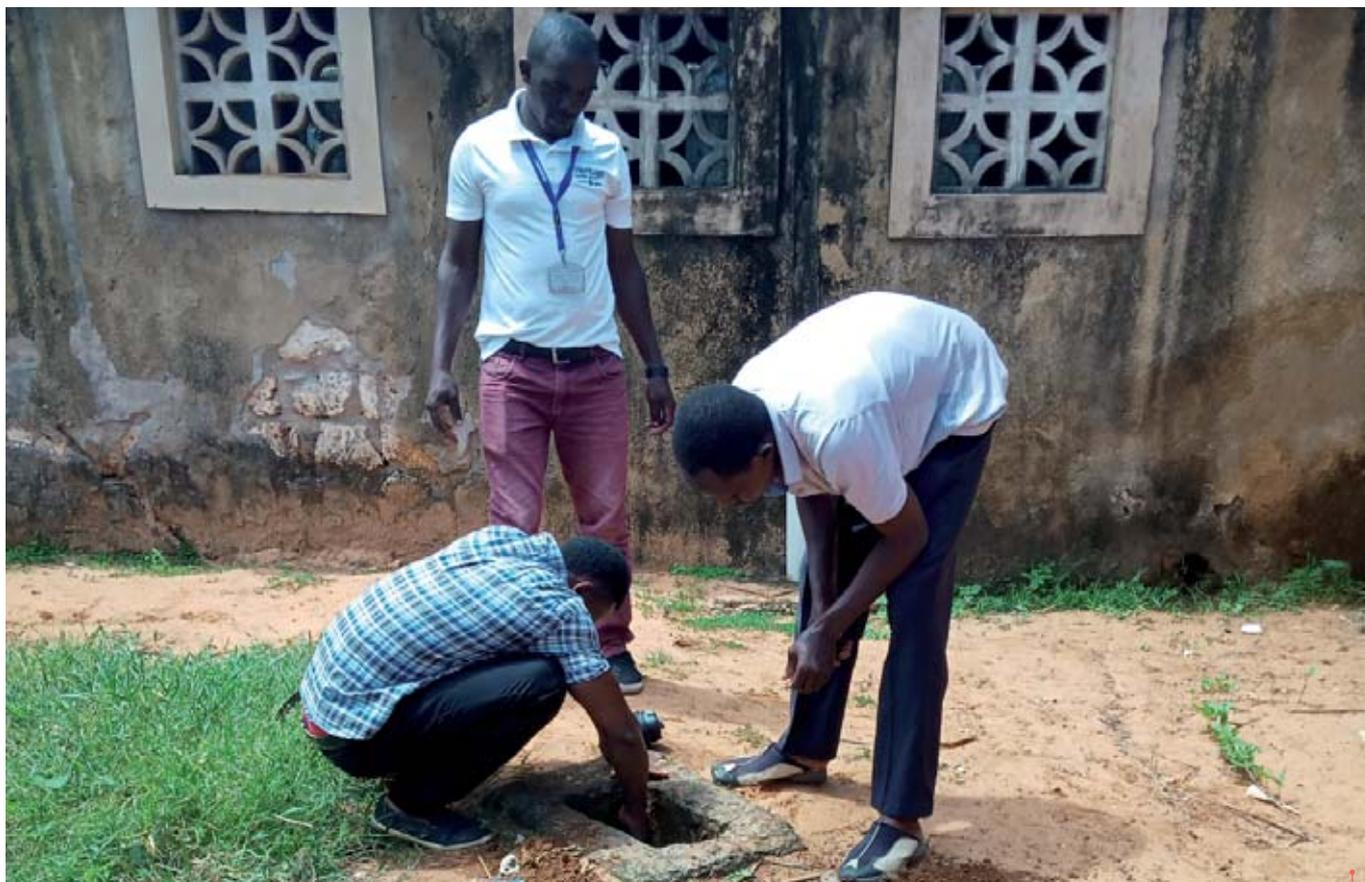
Le personnel de MAWASCO retire les compteurs mécaniques de la zone pilote - ©UNTAPPED
