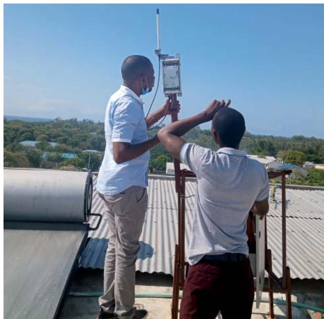
Configuration de l'antenne de communication d'un compteur intelligent - ©UNTAPPED
