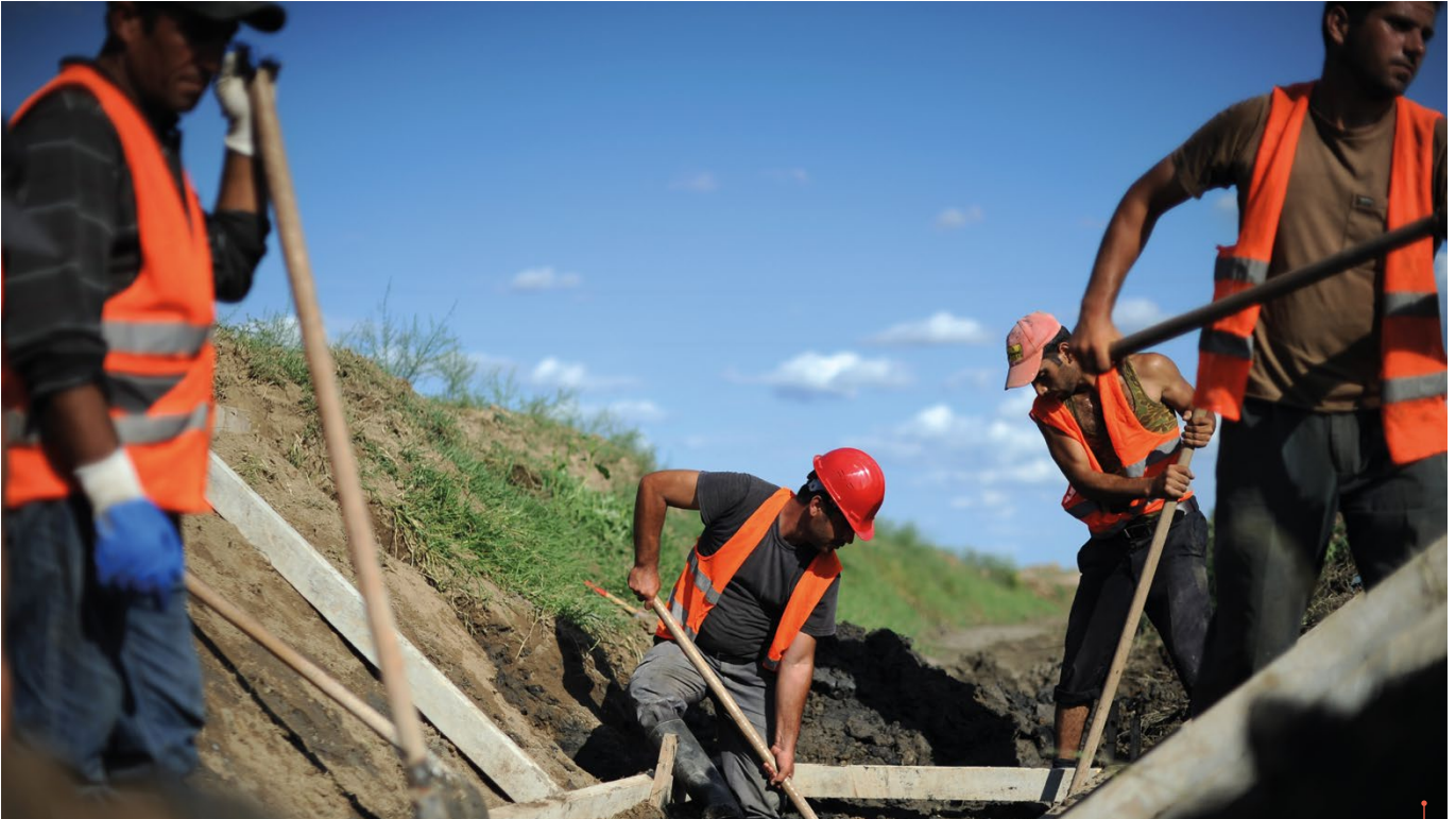
En Azerbaïdjan, un projet de développement des associations d'usagers de l'eau implique de nombreuses parties prenantes et contribue à améliorer l'irrigation et le drainage sur plus de 50 000 hectares de terres. Source : Allison Kwesell, Collection de photos de la Banque mondiale.
