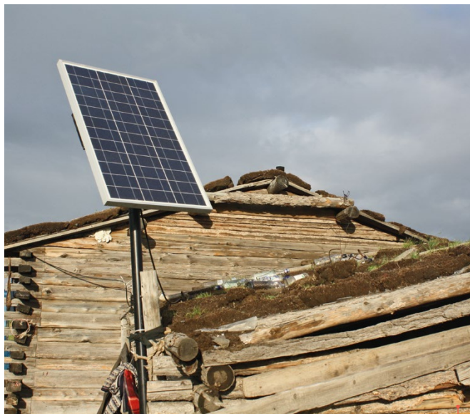
Les nouvelles technologies atteignent les campagnes. Production d'énergie solaire sur le toit d'une maison à Mungun Morit, en Mongolie. Source : Dave Lawrence.
